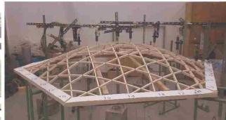
測地線グリッドシェル構造:直線部材の加工による製作性に優れた構造
